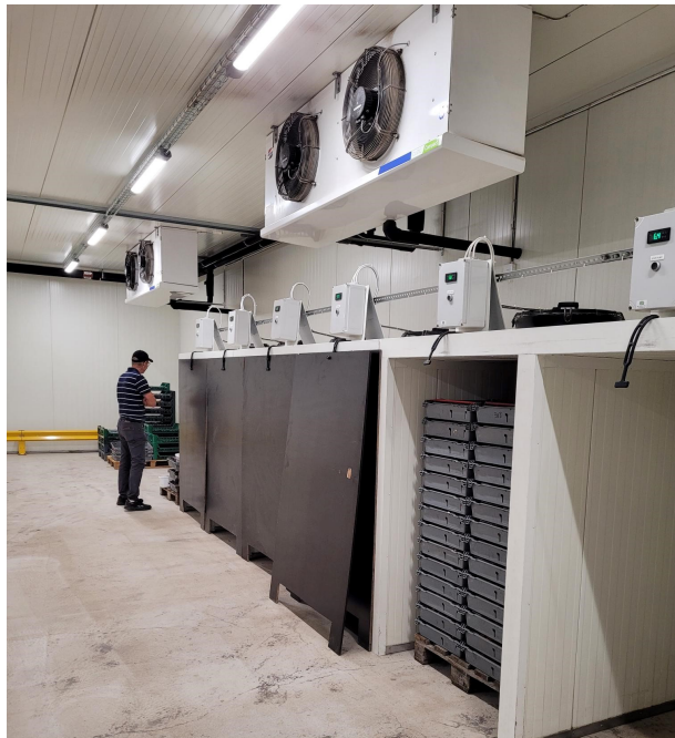
Figur 2. Snabb nedkylning av en pall i taget är effektivt för att snabbt sänka temperaturen. Fotograf. Jonas Jönsson, HIR Skåne
