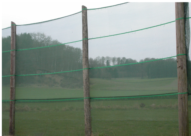
Vindnät skyddar tunnlar mot hårda vindar.
