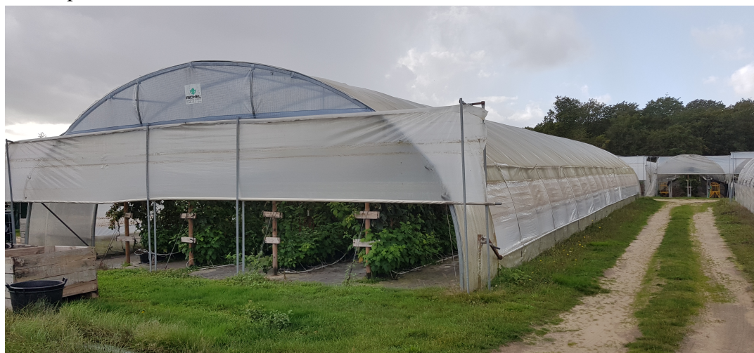
Eldrivna dörrar förenklar ventilering
